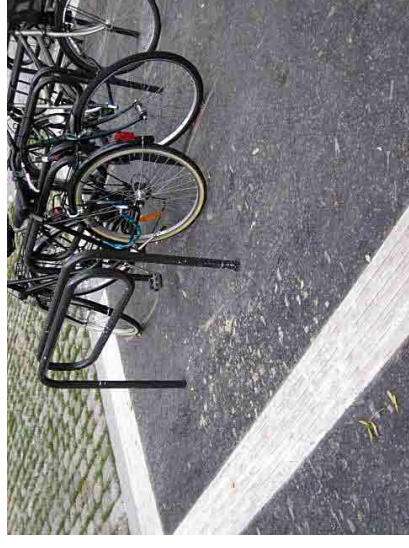
Dispositif expérimental de détection visuelle et tactile emprise zone de stationnement vélos sur trottoir
